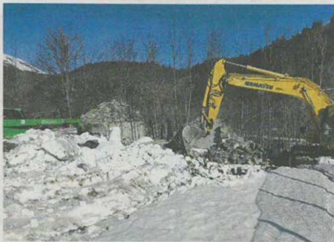
La demolizione delle casermette di Panice.
